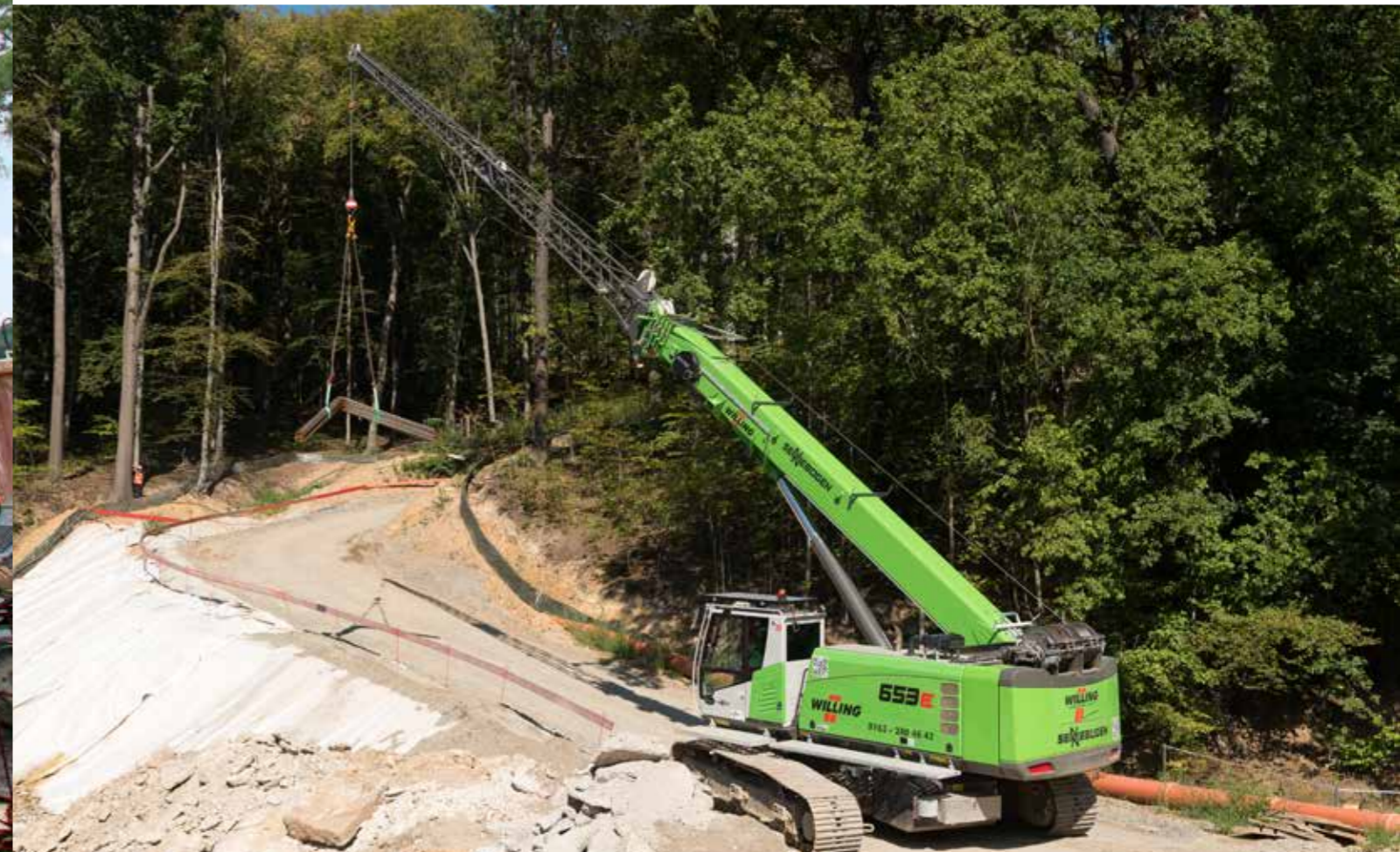
653 R - pick and carry operation in bridge building; Germany 653 R - Pick & Carry Einsatz beim Brückenbau; Deutschland
