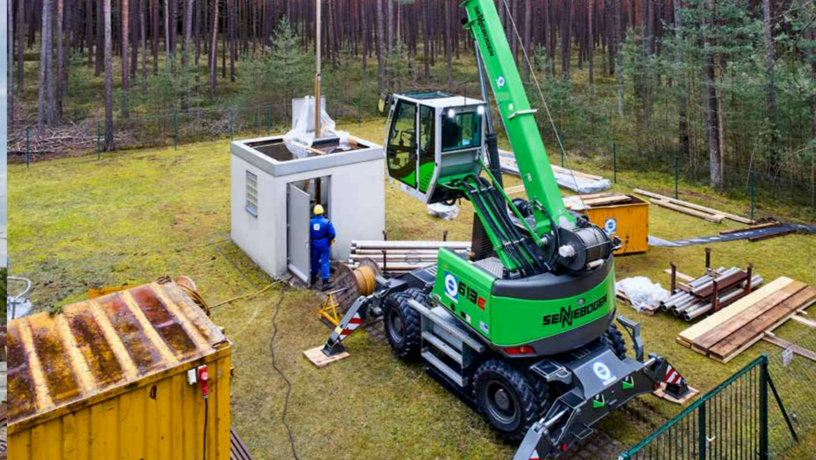
613 M – in use for well regeneration; Germany 613 M – bei der Brunnensanierung; Deutschland
