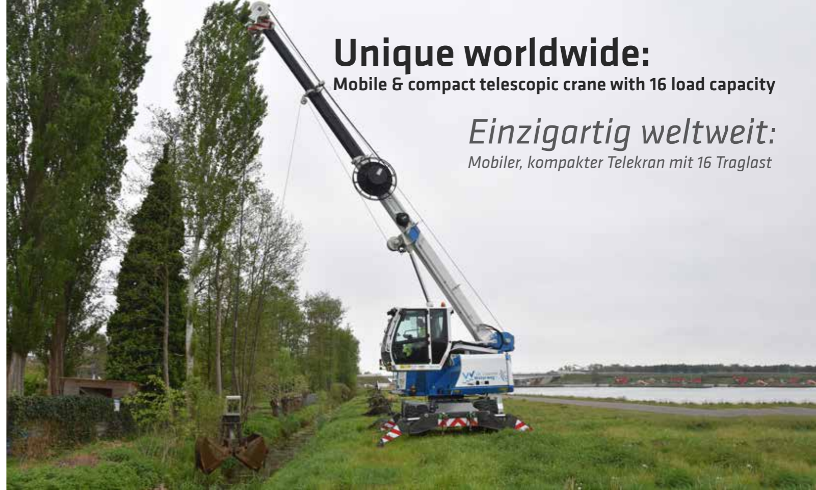
613 M - clamshell operation in hydraulic engineering; Denmark 613 M - Zweischalengreifer-Einsatz im Wasserbau; Dänemark
