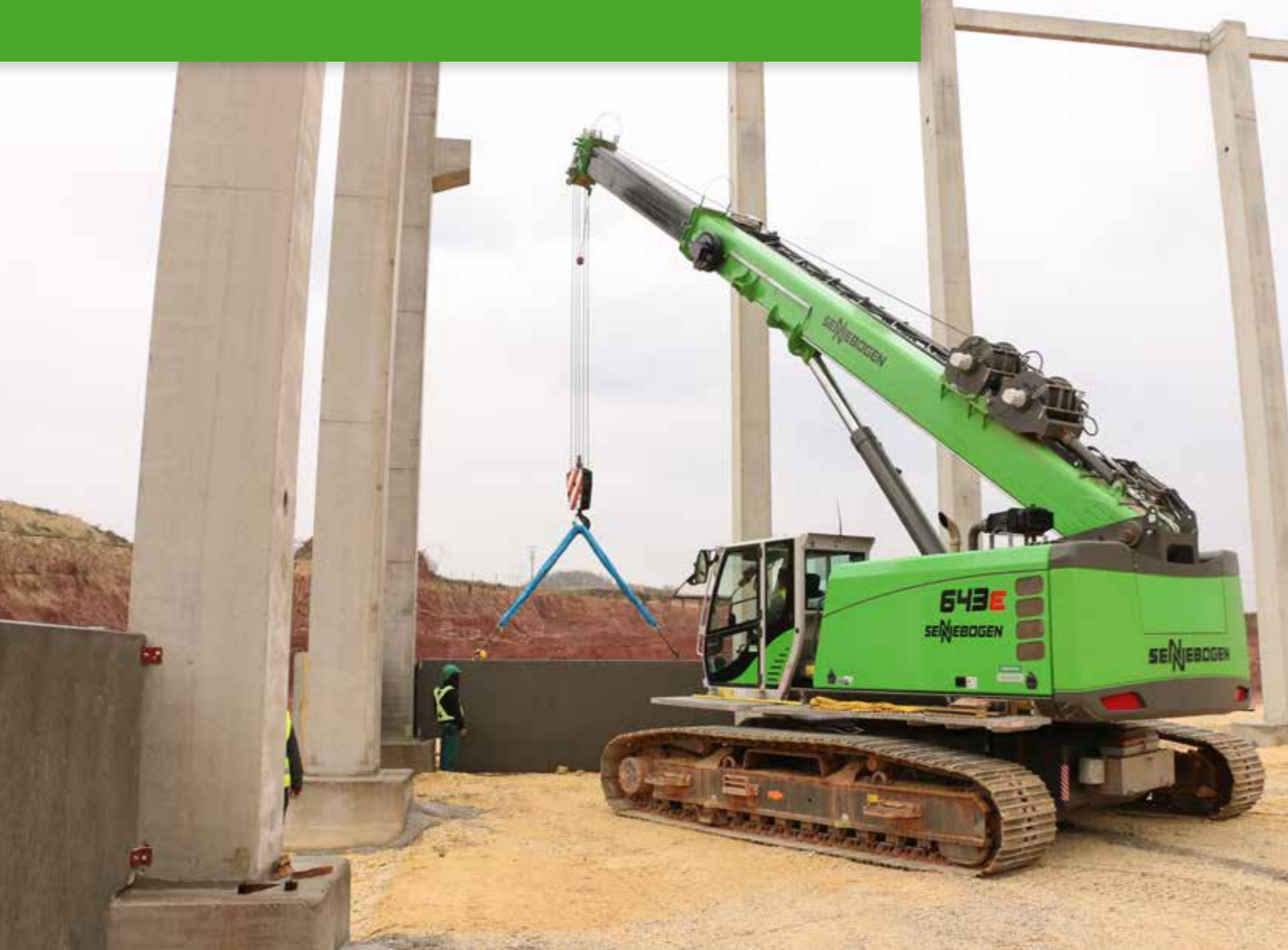
643 R - precast concrete parts assembly; Hungary 643 R - Betonfertigteilmontage; Ungarn
