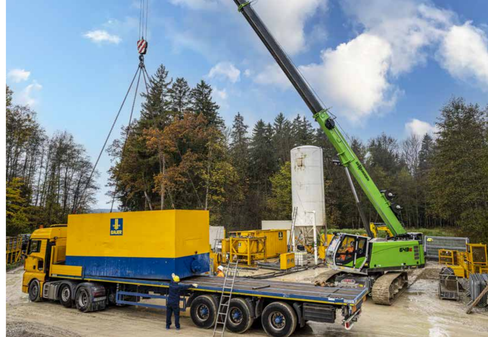
643 R - Construction site dismantling; Germany 643 R - Baustellenrückbau; Deutschland
