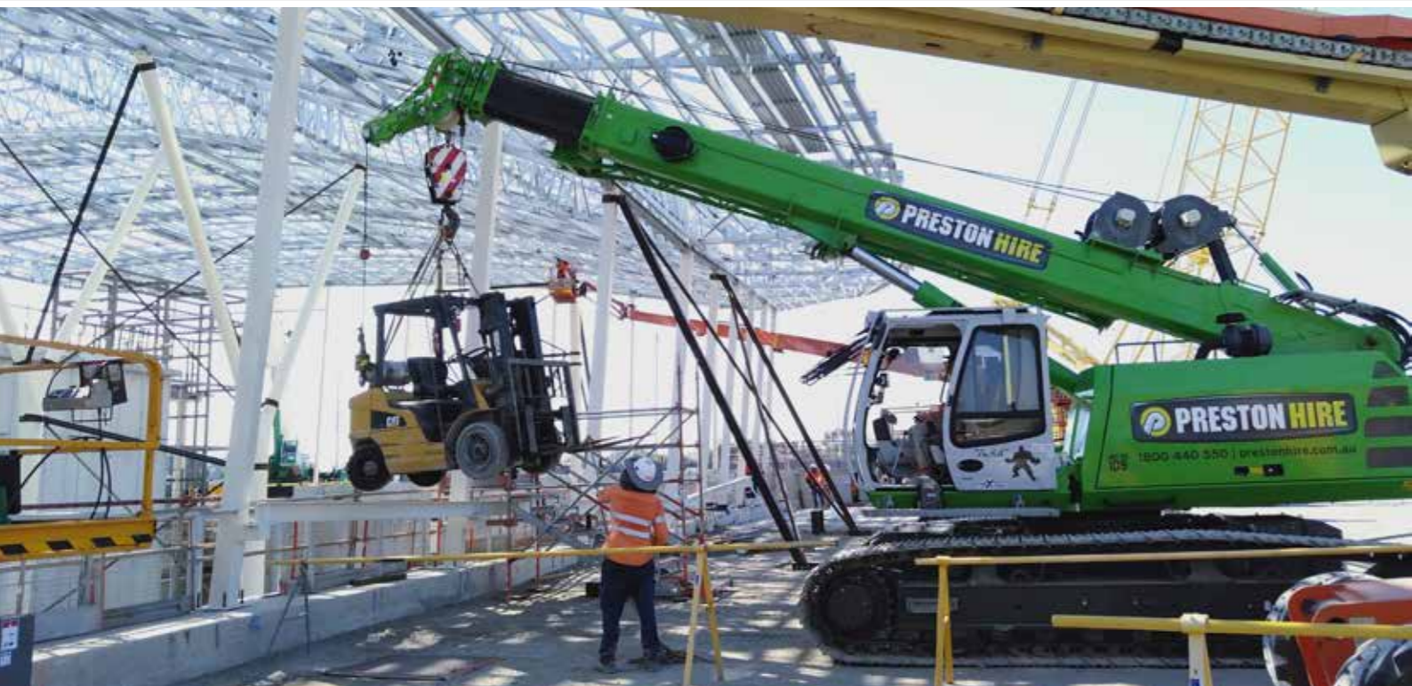
643 R - in use as service crane in railway construction; Australia 643 R - im Einsatz als Hilfskran beim Bahnbau; Australien
