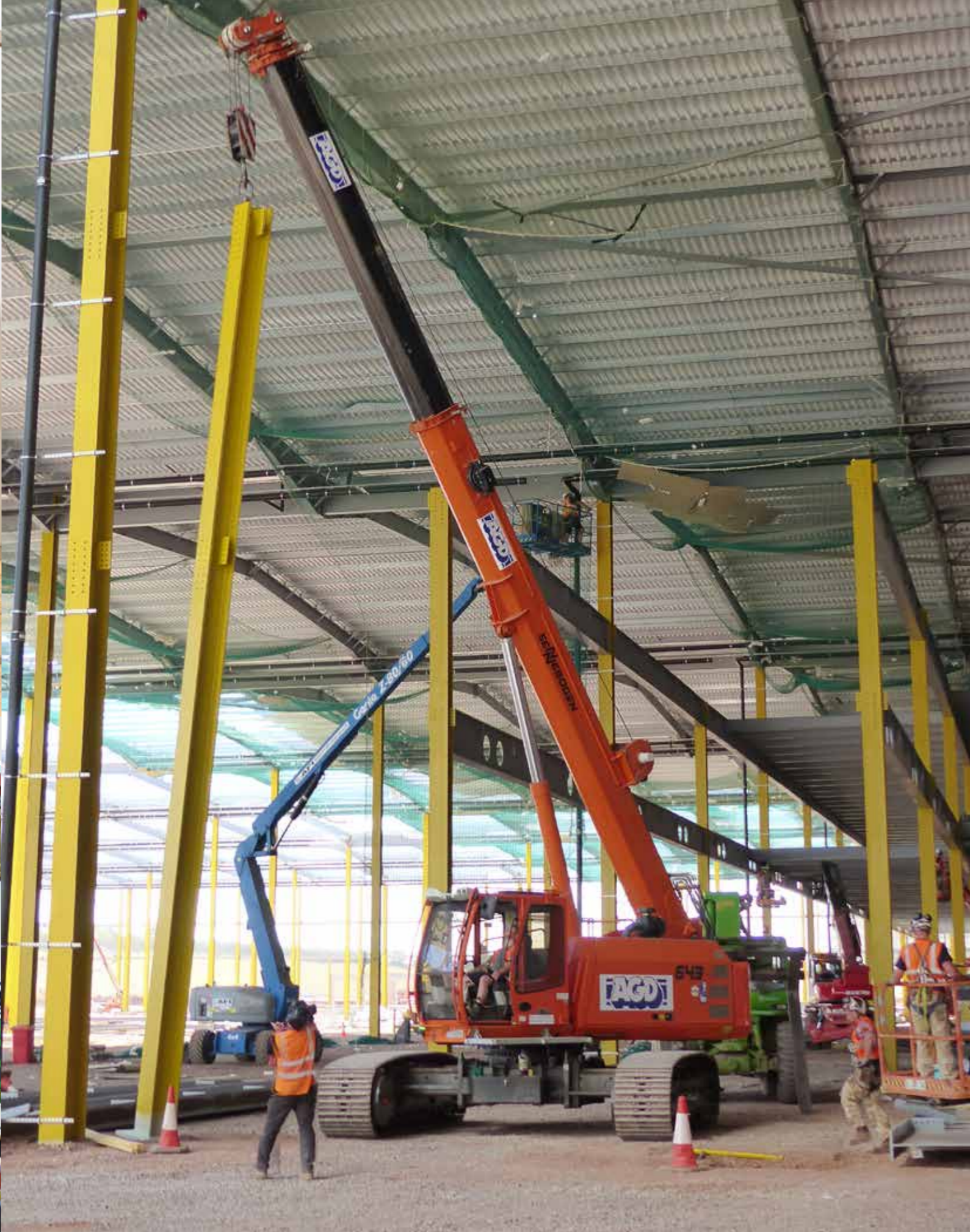
643 R - hall construction; UK 643 R - Hallebau; Großbritannien
