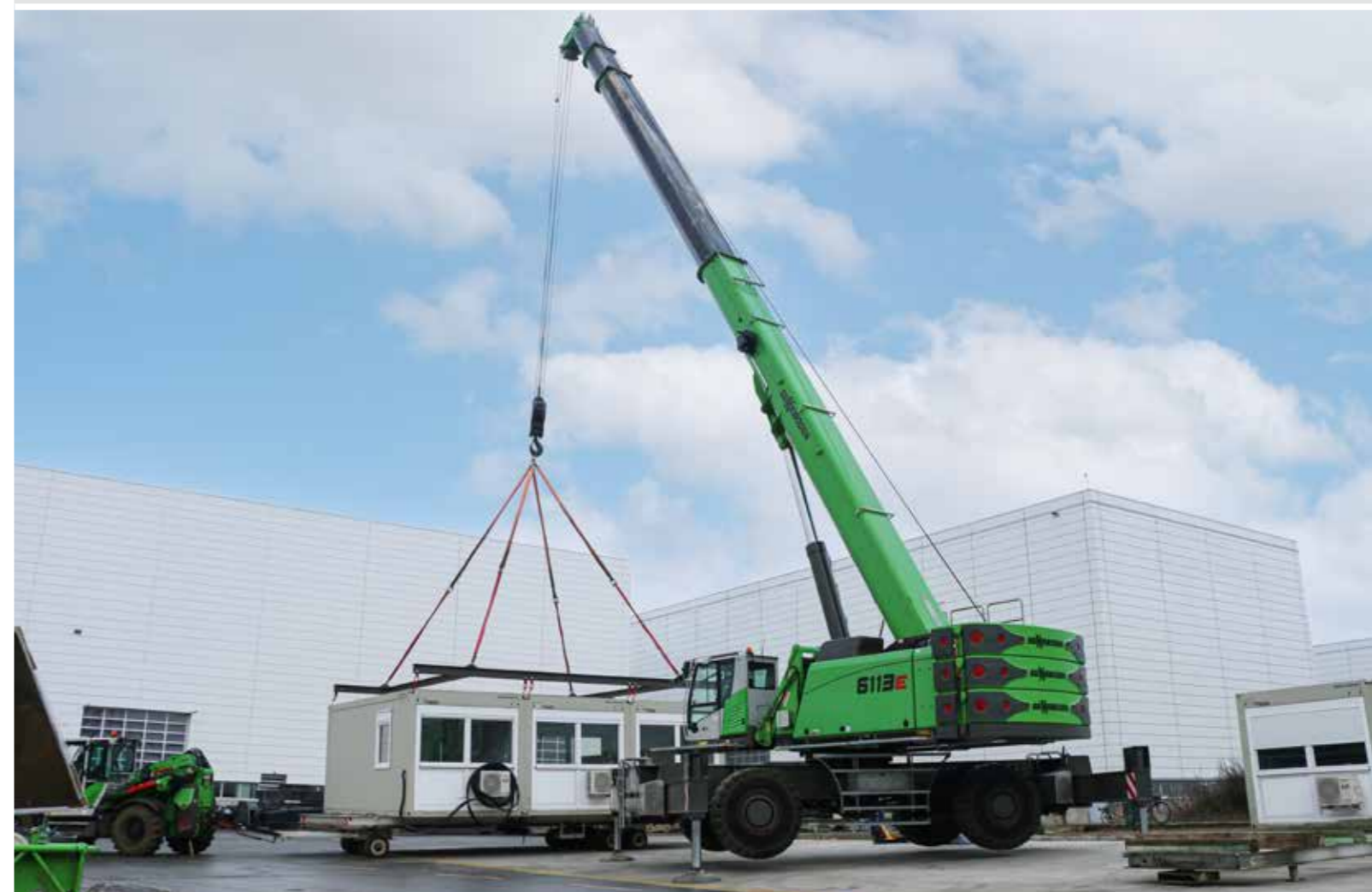
6113 M - positioning of office containers; Germany 6113 M - Platzierung von Bürocontainern; Deutschland
