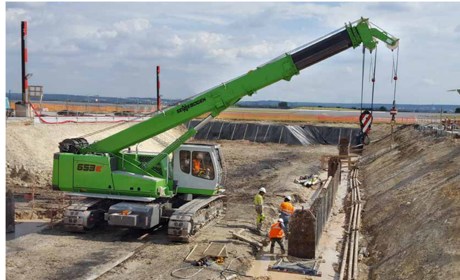
653 R - Civil and underground engineering at an airport; France 653 R - Tiefbauarbeiten auf einem Flughafengelände; Frankreich
