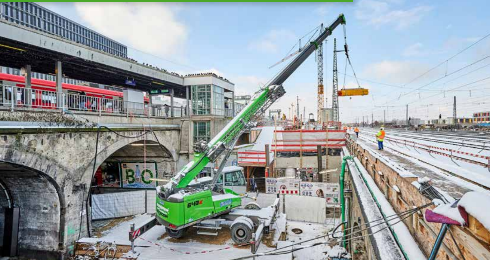
643 M - Civil engineering, operation via radio remote control; Germany 643 M - im Hoch- / Tiefbau, Steuerung via Funkfernbedienung; Deutschland
