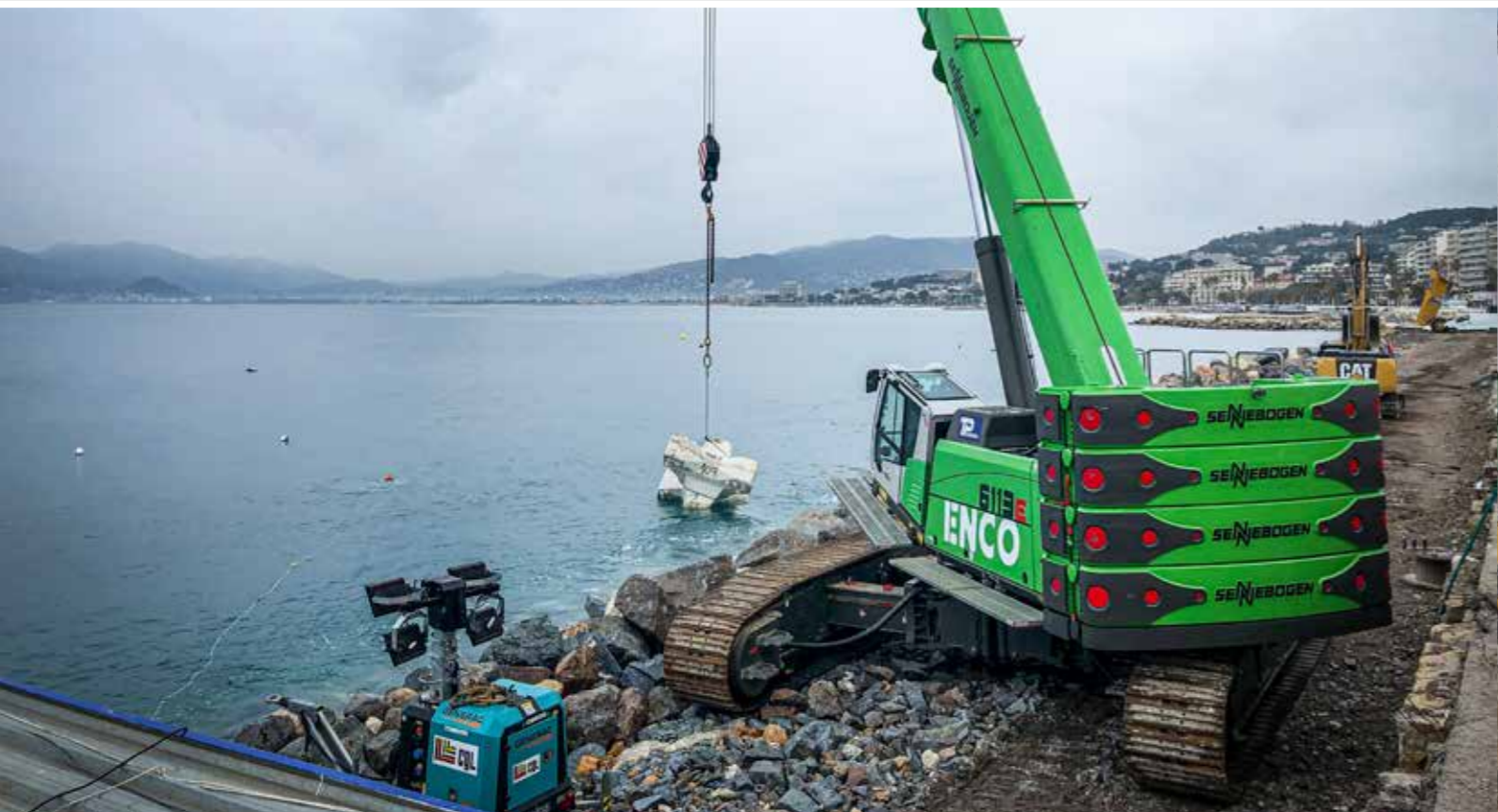
6113 R - coastal protection works; France 6113 R - Küstenschutzarbeiten; Frankreich
