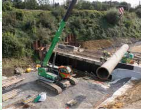
Pipe installation works Rohrlegearbeiten
