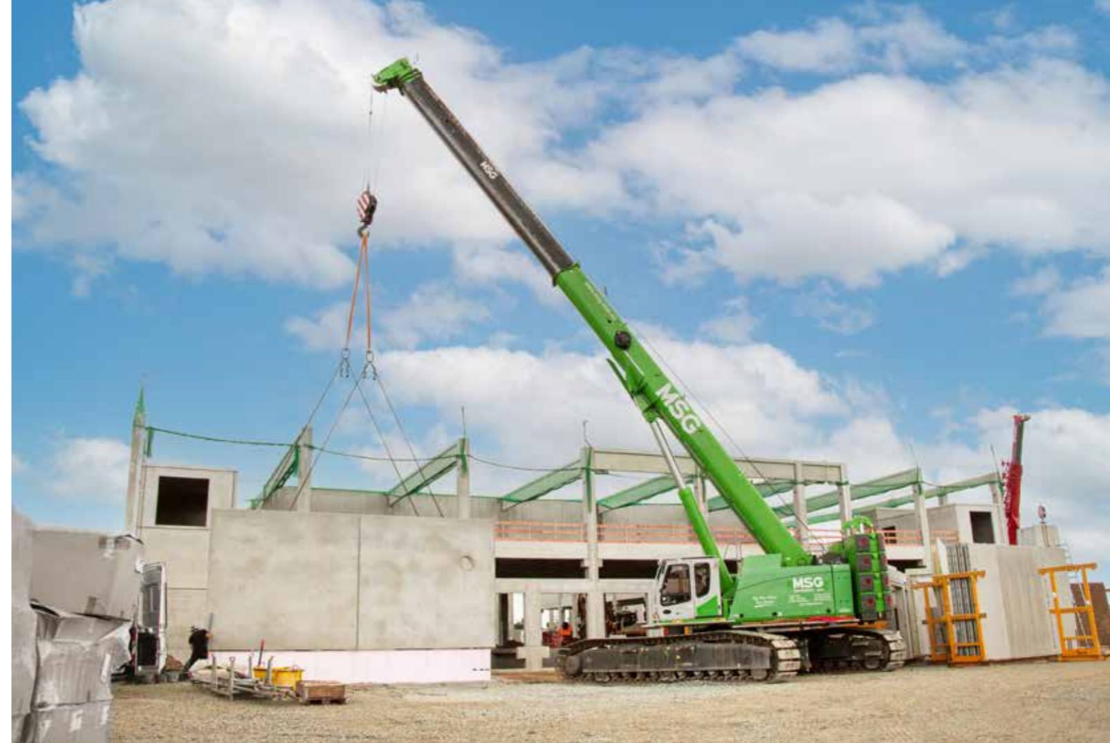
6113 R - lifting and moving heavy loads in prefabricated concrete parts assembly; Germany 6113 R - heben und transportieren schwerer Lasten bei der Betonfertigteilmontage; Deutschland
