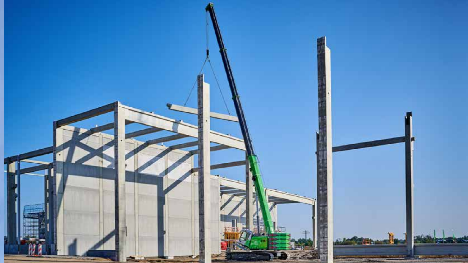
673 R - prefabricated concrete parts assembly; Germany 673 R - Betonfertigteilmontage; Deutschland
