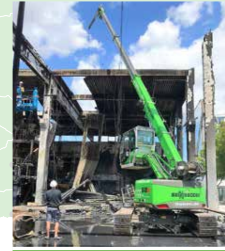
Demolition & Dismantling Abbruch & Rückbau
