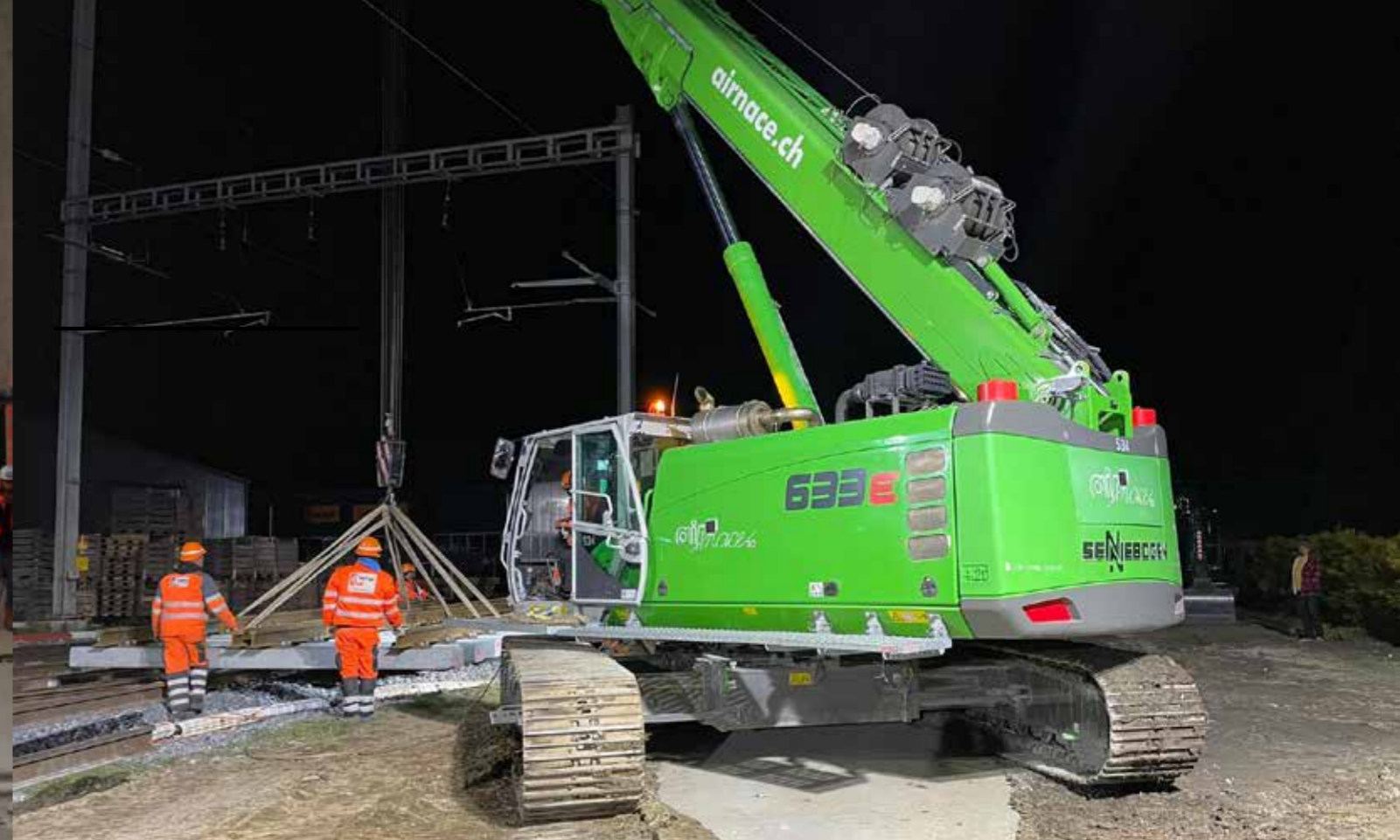
633 - rail installation; Switzerland 633 - Schienenverlegung; Schweiz
