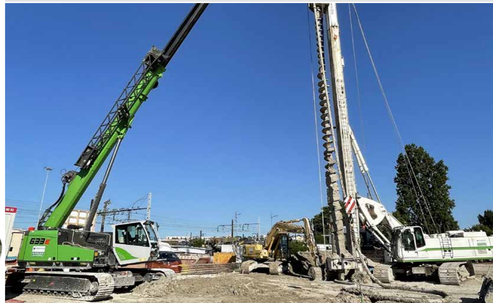
633 R - 633 - as auxiliary crane for drilling operations; France 633 R - als Hilfskran bei Bohrarbeiten; Frankreich
